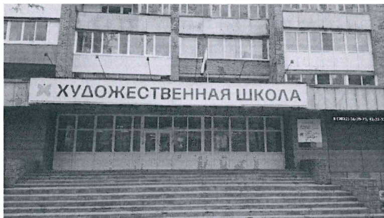
Рисунок 1 – Фотофиксация главного фасада ДХШ №2
